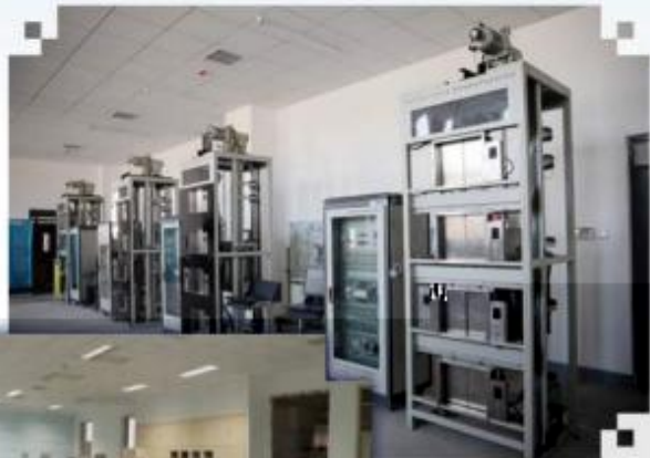
智能电梯安装调试 维护训练场所
